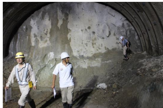
写真1 上野トンネル内部
